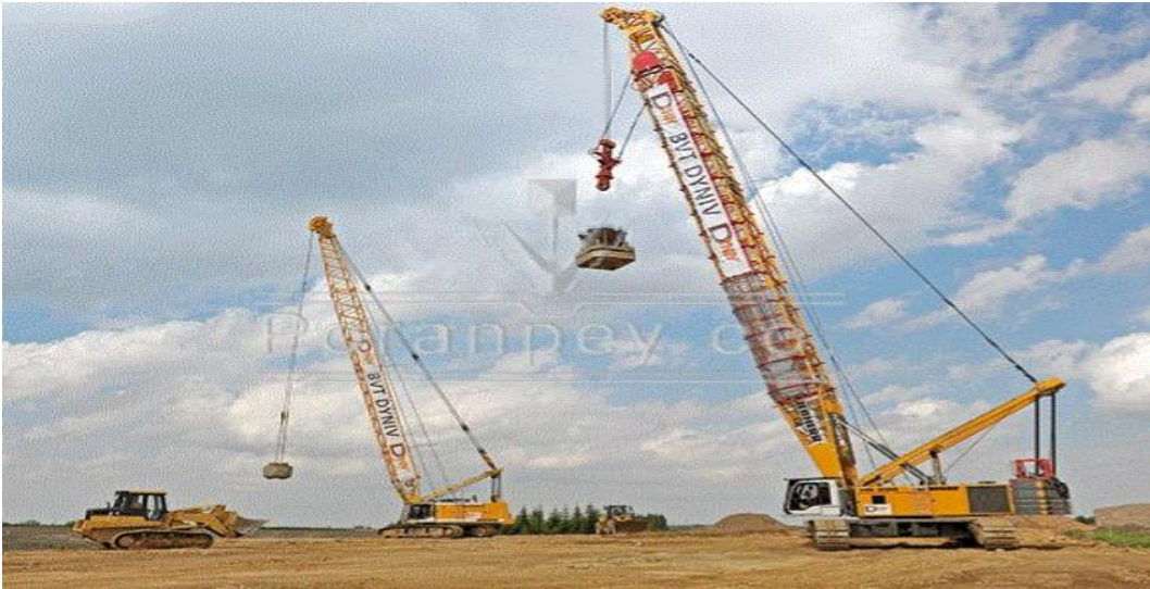
شکل ۱. تراکم دینامیکی روش بهسازی خاک
